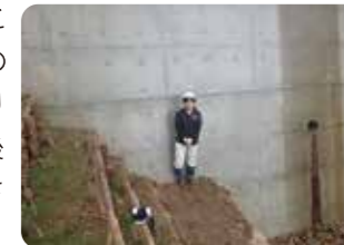
森林土木復旧工事現場にて
